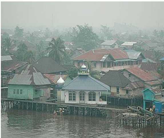
Kondisi Topografis Yang Membuat Sebagian Pemukiman Berada Di Atas Sungai
