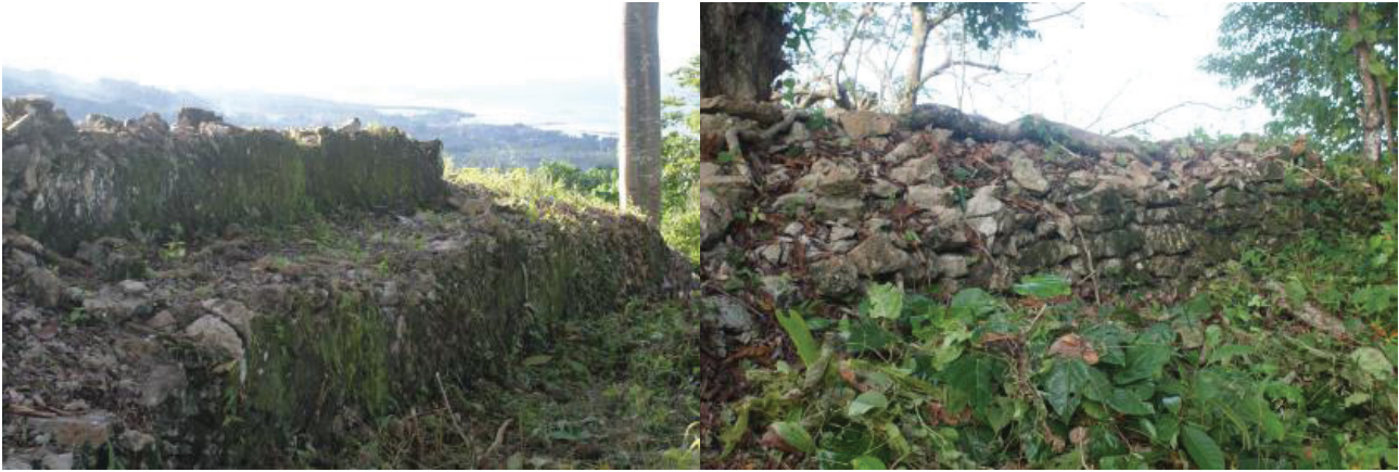
Gambar 2. Dinding benteng dengan lapisan kalero (kiri) dan tanpa lapisan (kanan). (Sumber: Dokumen Balai Arkeologi Manado)
