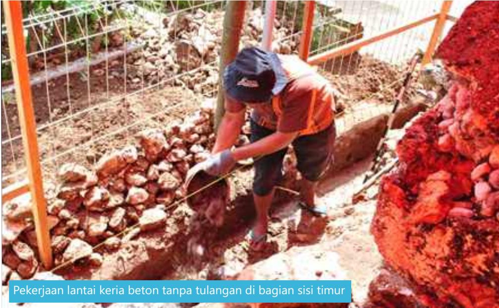
Pekerjaan lantai keria beton tanpa tulangan di bagian sisi timur
