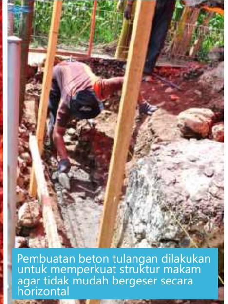
Pembuatan beton tulangan dilakukan untuk memperkuat struktur makam agar tidak mudah bergeser secara horizontal
