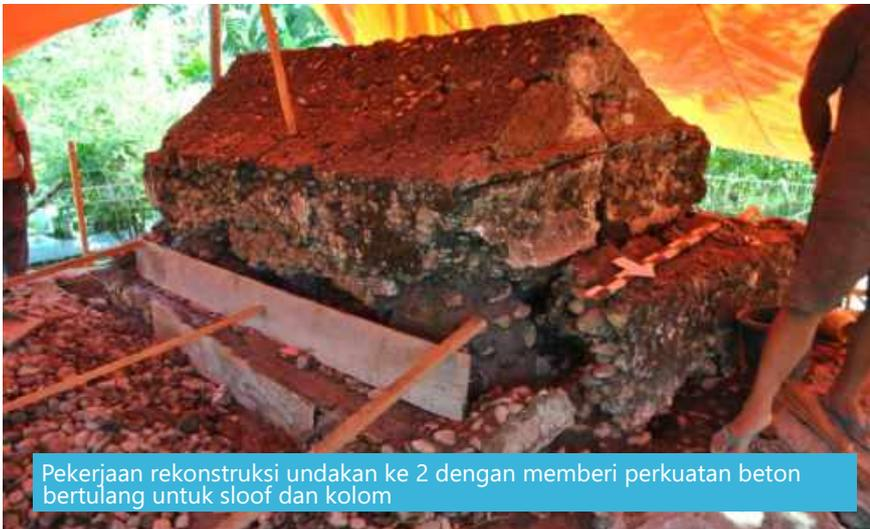
Pekerjaan rekonstruksi undakan ke 2 dengan memberi perkuatan beton bertulang untuk sloof dan kolom
