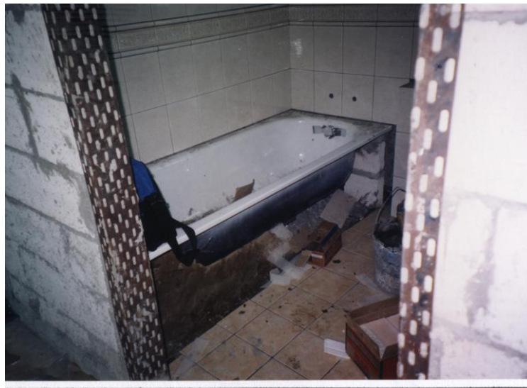
Gambar 8.18 Pemasangan Bath tub
