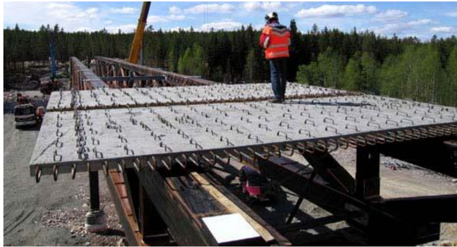
Gambar 7.14 Pemasanganlantai precast diatas jembatan kayu.
