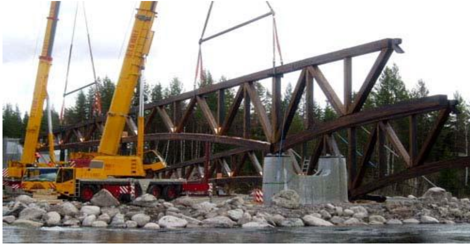
Gambar 7.12 Erectionjembatankayulaminasi.
