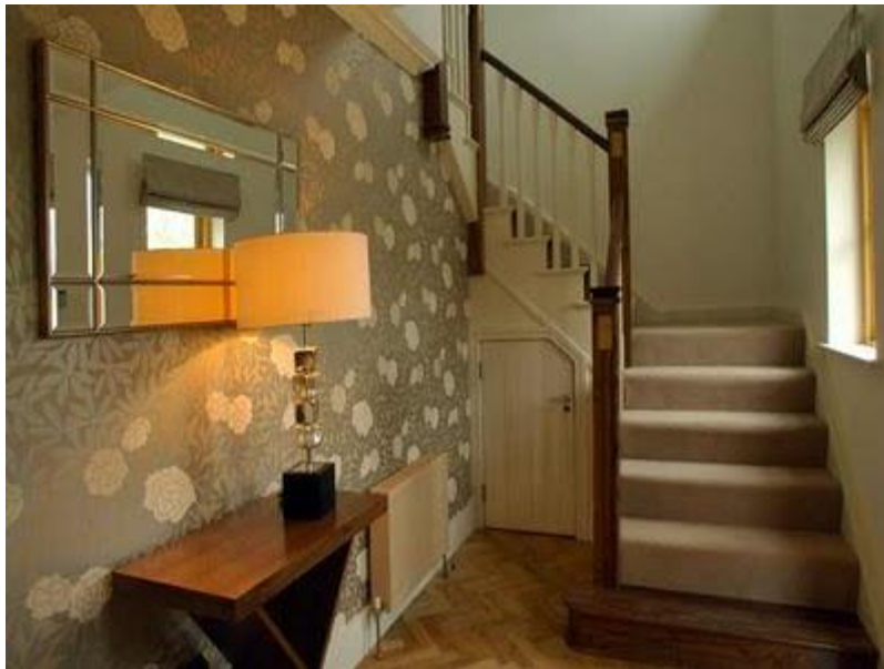
Gambar 6. 2 Tangga Berbelok arah model L
