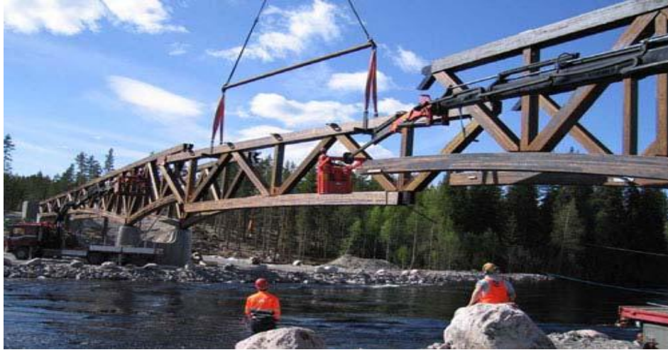
Gambar 7.13 Proses erection jembatan kayu sungai Rena
