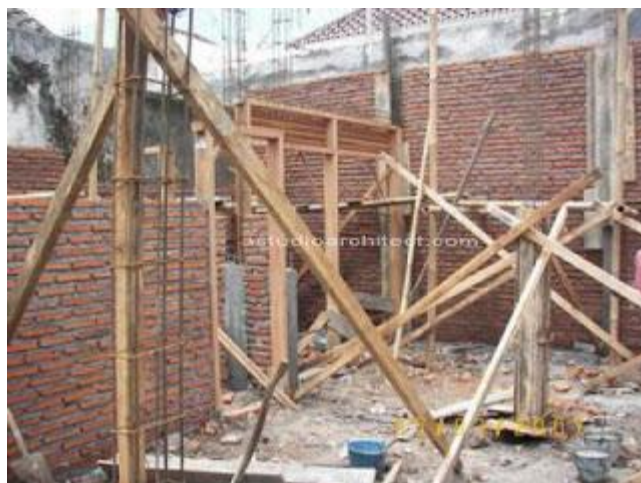
Gambar 5. 19 Gambar tulangan kolom, sedang dikerjakan bersama pembuatan dinding.
