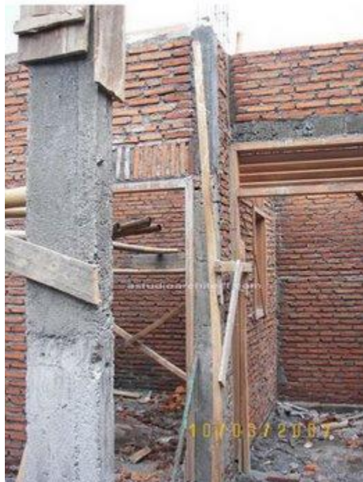
Gambar 5. 20 Pekerjaan kolom yang sudah jadi.
