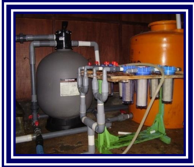
Gambar 3. Sandfilter dan Cartridge
