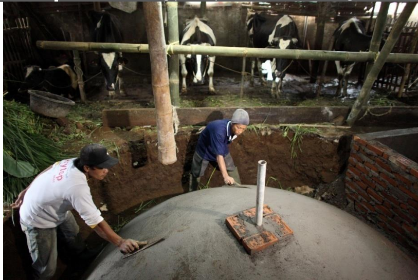
Gambar 4. 20 Finishing penutup konstruksi reaktor biogas
