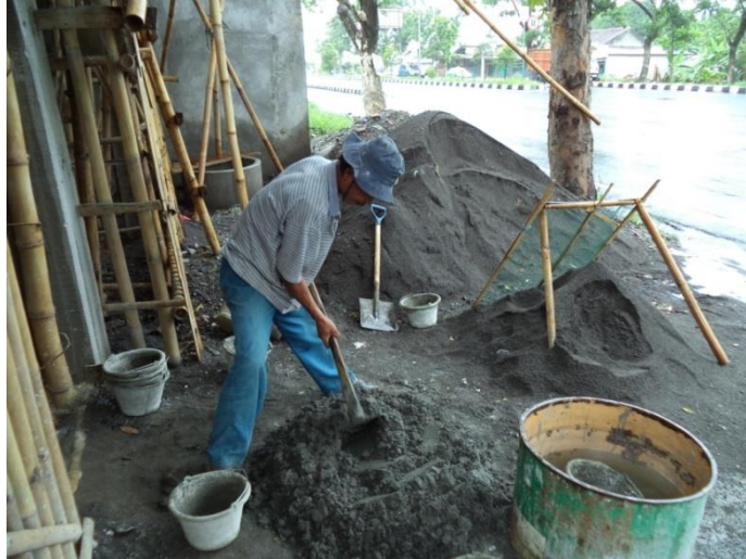
Gambar 2. 60 Pembuatan adukan secara manual
