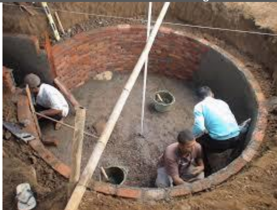
Pemlesteran biodigester
