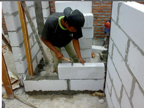
Gambar 2. 76 Pemasangan lapisan kedua
