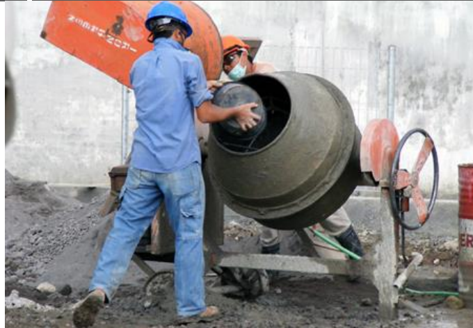
Molen sebagai pengaduk pasangan bata
