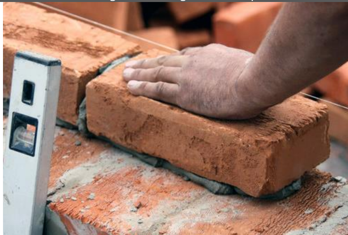
Pemasangan bata dengan bantuan profil
