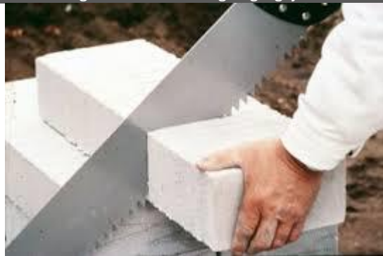
Gambar 2. 71 Pemotongan batu bata dengan gergaji
