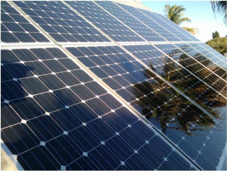
Gambar xx. Bayangan dapat mengurangi produksi energi listrik PV modul
