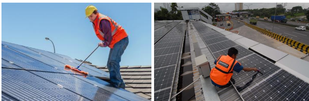
Modul surya yang kotor karena debu atau kotoran lainnya perlu dibersihkan
