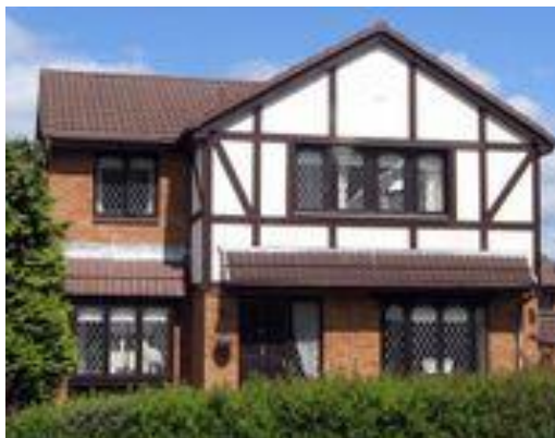
Gambar 2.31: Rumah modern yang menggunakan PVC yang bercorak kayu untuk pintu dan jendela
