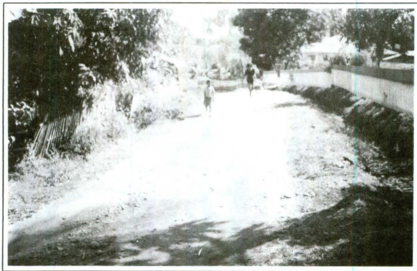
Gambar 6. Jalan desa yang telah dikeraskan dengan batu
