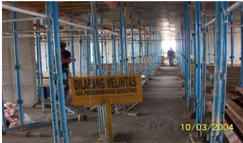
Gambar.Rambu-Rambu Pada Pekerjaan Bekisting
