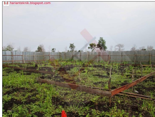
Pekerjaan Bouwplank
