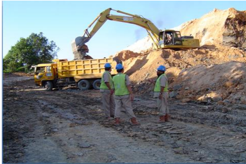
Gambar. Excavator pada Pekerjaan Tanah Mekanis
