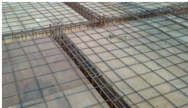
Gambar 3.24. Rangkaian tulangan balok dan plat lantai pada bekisting.
