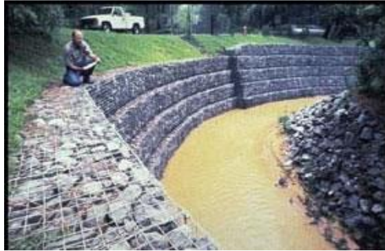
Gambar 3.9 Tembok Batu untuk mencegah erosi
