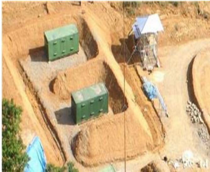
Gambar 5.11 Lokasi gudang handak
