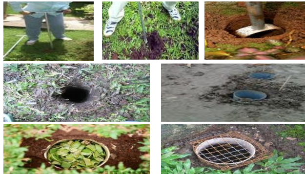
Gambar 1.5 Cara Pembuatan Lubang Resapan Biopori
