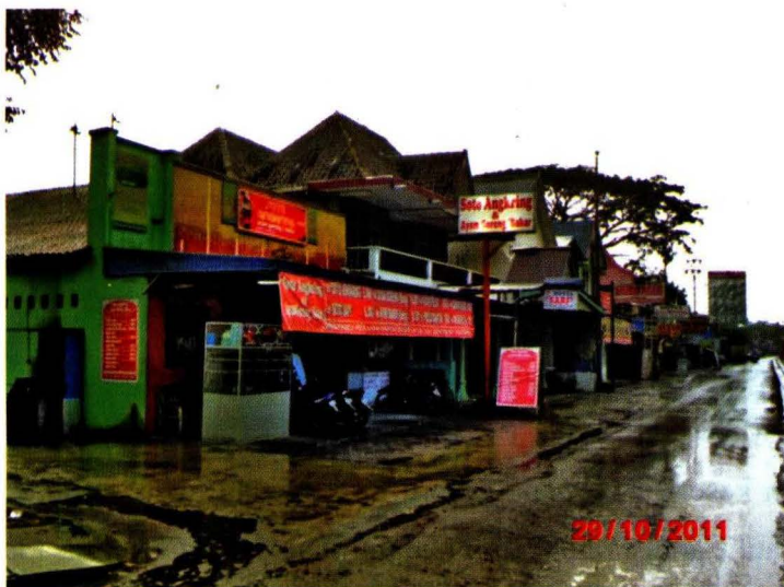
Foto 31. Kios Makanan dan Minuman di Jalan Prambanan-Klaten
