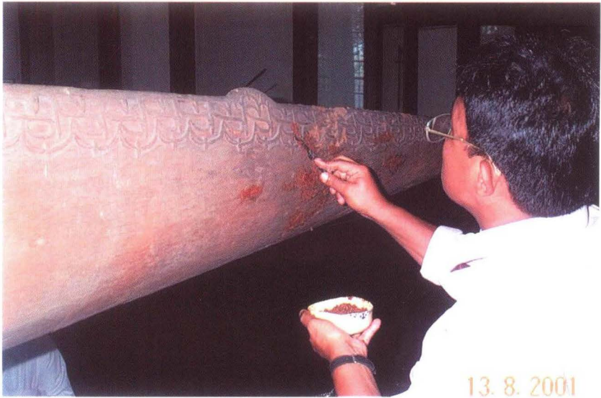
Pengisian bagian-bagian yang retak/berlobang.
