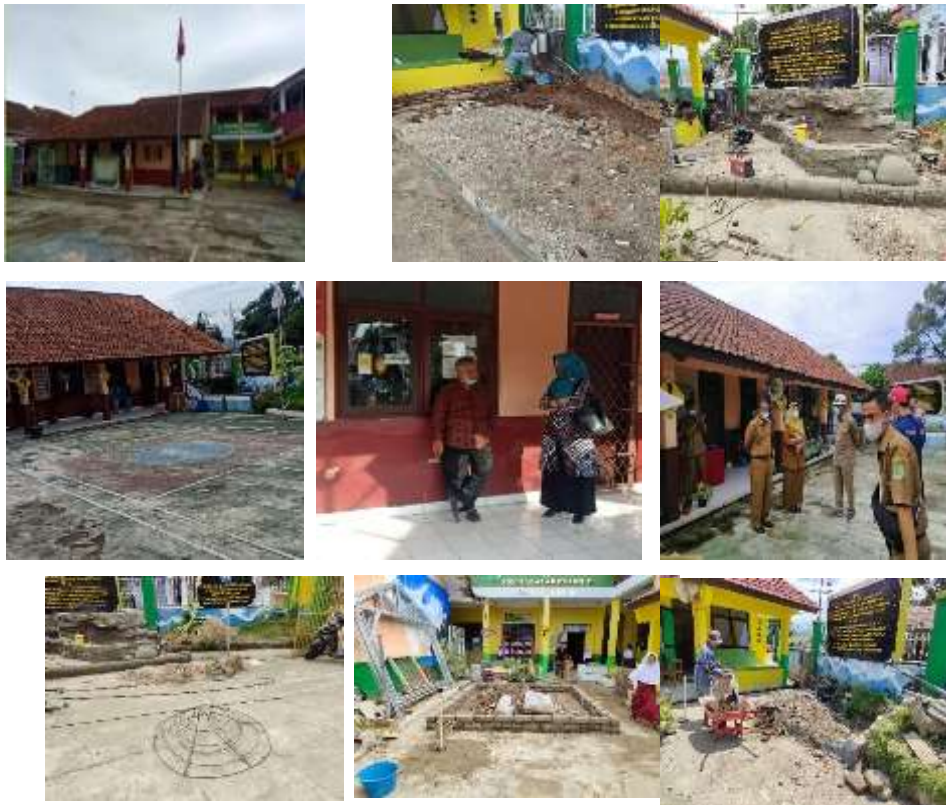
Gambar 1 Kondisi awal lingkungan sekolah
