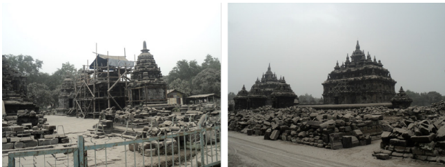
Gambar 2.6 Dampak Letusan Gunungapi Merapi 2010 terhadap Cagar Budaya (Sumber: BPCB Jawa Tengah)
