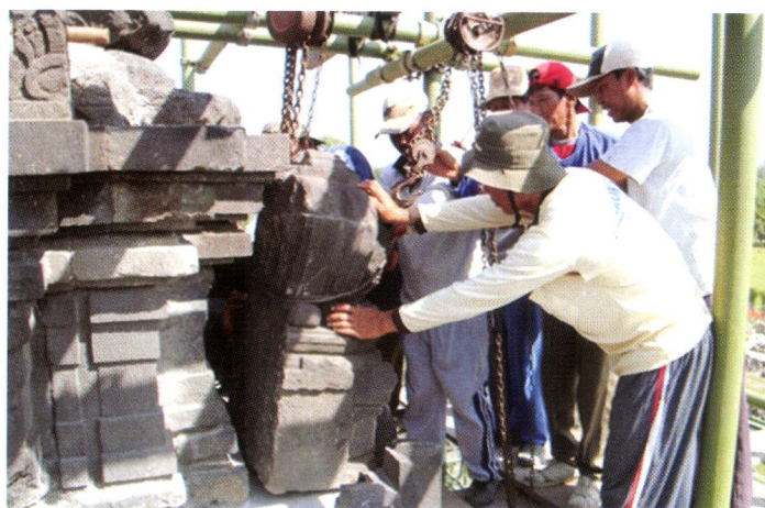
Pemasangan kembali ratna atap
