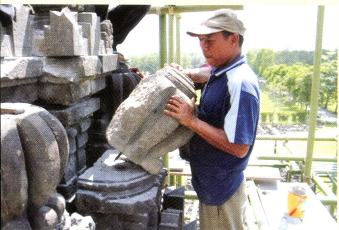
Perkuatan angkur pada Ratna atap Candi Apit Utara
