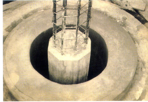
Perkuatan beton bertulang pada pemugaran Candi Siwa tahun 1950-an
