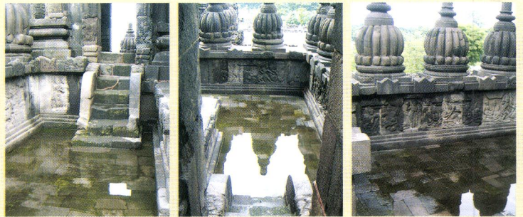
Genangan air pada lantai selasar (langkan) Candi Siwa
