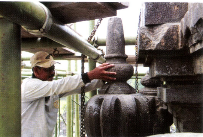
Pemasangan kembali pinakel ratna atap
