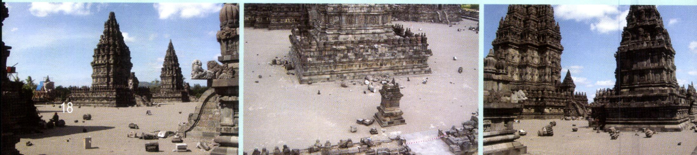
Kerusakan pasca gempa
