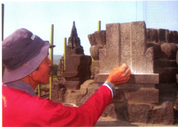
Pemasangan tanda batu baru
