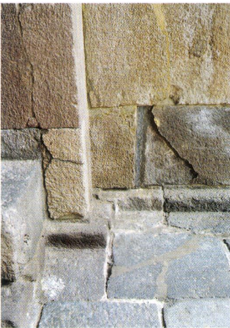
Kondisi hasil retakan setelah dilakukan rehabilitasi
