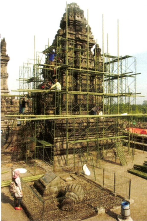
Kegiatan pemasangan perancah
