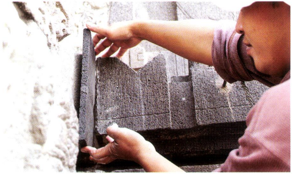
Pemasangan batu pengganti
