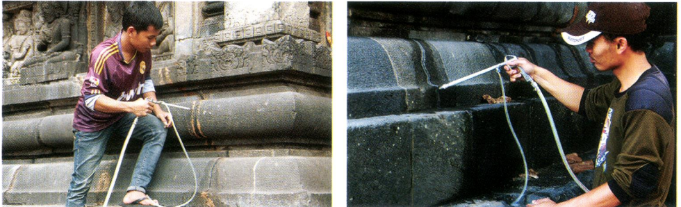
Injeksi Mortar Hidrolik
