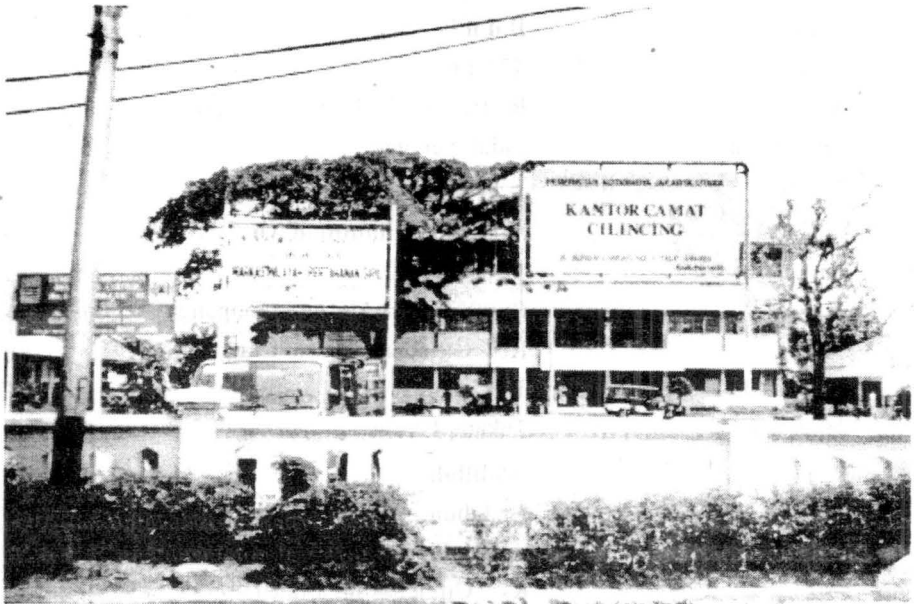
Kantor Kecamatan Cilincing Jakarta Utara
