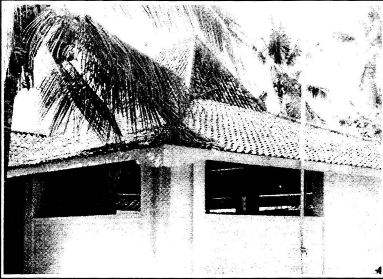
Salah satu bangunan tua milik seorang ningrat di kampung loteng. Bangunan bagian samping rumah tua yang sudah mulai rusak
