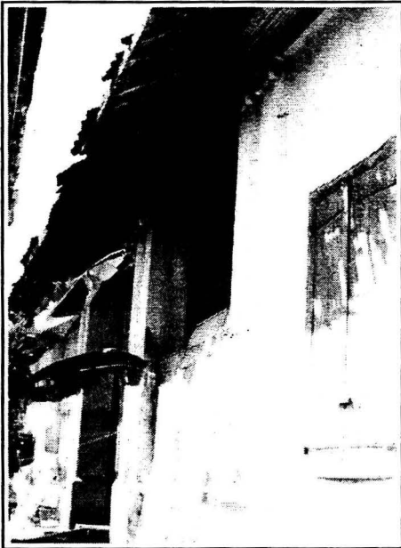
Bangunan bagian samping rumah tua yang sudah mulai rusak dimakan usia.
