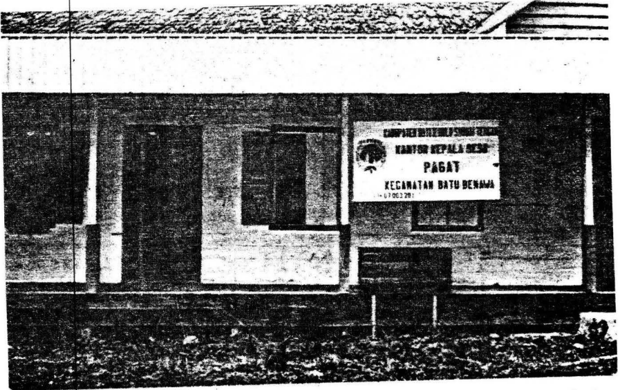
Kantor Kepala Desa Pagat, bertempat di sebuah bilik bangunan bekas Kantor Kecamatan Batu Benawa.
