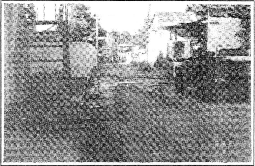
Kondisi salah satu jalan di Kelurahan Sukabungah
