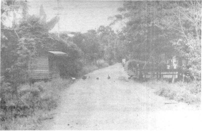
Gambar 1.5 Jalan Menuju Sungaibatang
