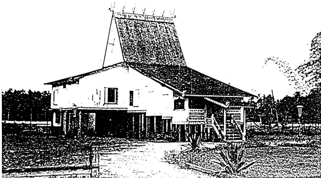
Rumah Adat Banjar Bubungan Tinggi yang anggun tampak berwibawa. atap bubungan yang lancip seperti menusuk langit, didukung atap Sindang Langit dan Hambin Awan.
