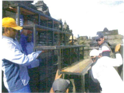
Foto 2.2.10. Desain Knock Down pada Model Pelapis Tangga Candi dengan Kerangka Besi
