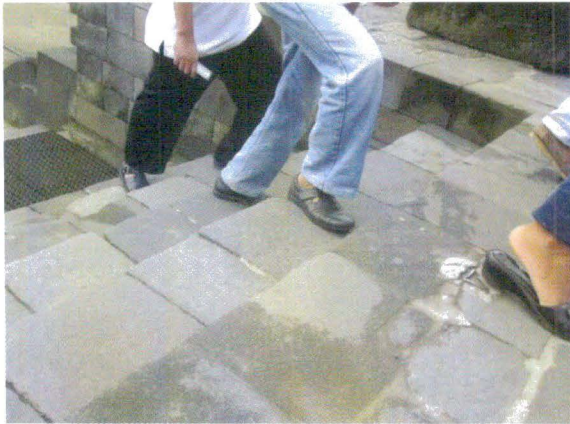
Foto 2.2.2. Kondisi tangga undag – Selasar pada sisi Timur dan aktifitas pengunjung yang melewati tangga.
