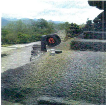
Foto 4.3.2 Posisi target monitoring dan prisma target monitoring
