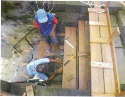
Foto 2.2.7. Proses Pemasangan Dataran Pijak pada Pembuatan Pra Desain Model Pelapis Tangga
