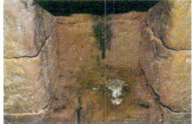
Foto 8.2.8 Lapisan hitam dan bekas lelehan lilin di dalam relung pada Candi Gedong 1
