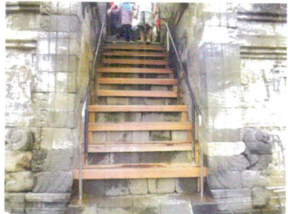
Foto 2.2.8. Hasil Akhir Pembuatan Pra Desain Model Pelapis Tangga Berbahan Kayu dengan Susunan Melintang
