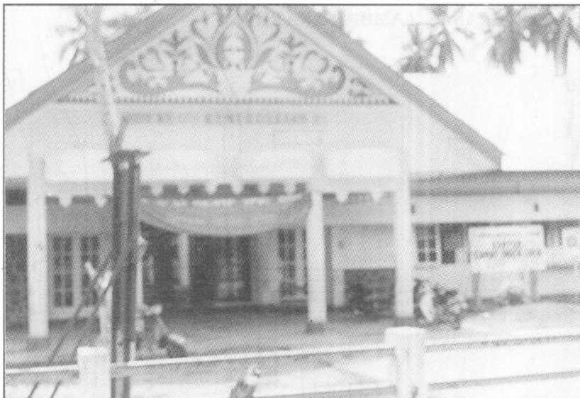
Gbr. 1. Kantor Camat Kecamatan Ingin Jaya Kabupaten Aceh Besar.
