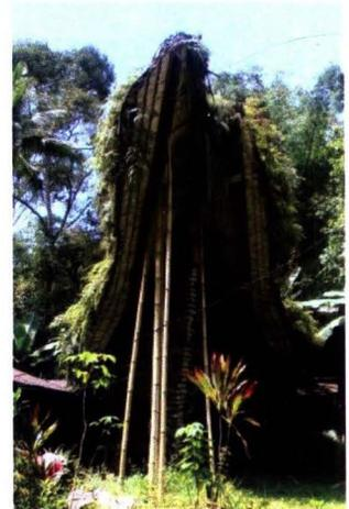
terutama pada bagian atap yang terbuat dari bambu banyak ditumbuhi rerumputan dan hampir roboh, sehingga dipergunakan tiang-tiang bambu untuk menopang bagian atap tersebut. Hal ini diperparah dengan kondisi rumah yang sudah lama tidak dihuni mengingat keturunan dari Tongkonan Lombok ini mempunyai tempat tinggal sendiri di sekitar tongkonan.
