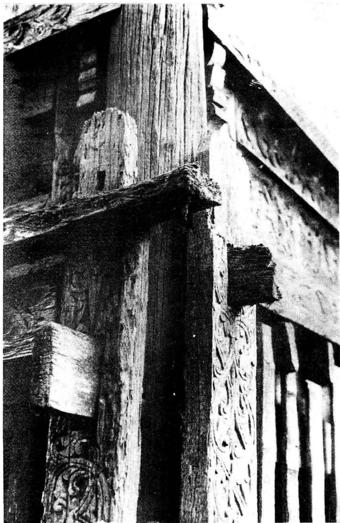
Rumah Gadang Bapaserek di kanagarian Kete nan Ampek Payakumbuh dilihat dari sudut depan dan bagian dari konstruksi tiang pada salah satu sudutnya.
