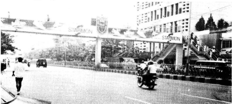
Gambar 5. Jembatan Penyebrangan di Jalan Utama
