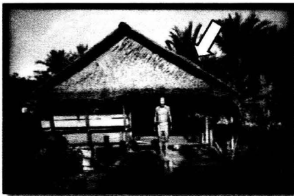
Foto 4 & 5. Tobat atau atap yang terbuat dari anyaman daun sagu (rumbia)
