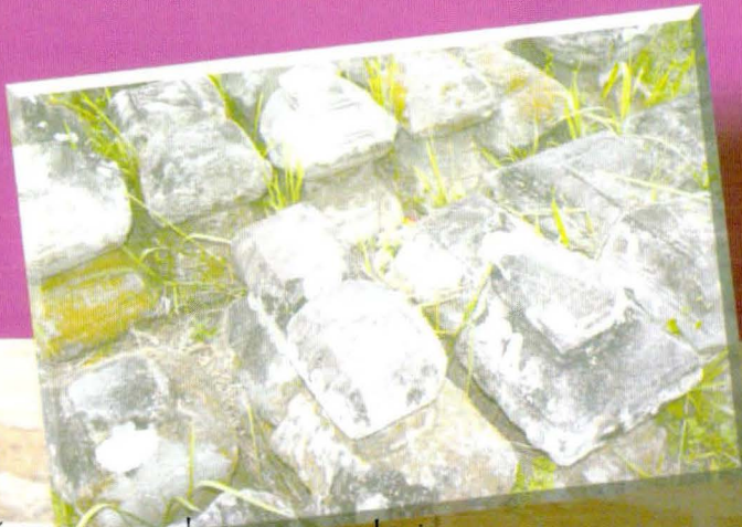
Komponen bangunan dari batuputih di Candi Bahal II
