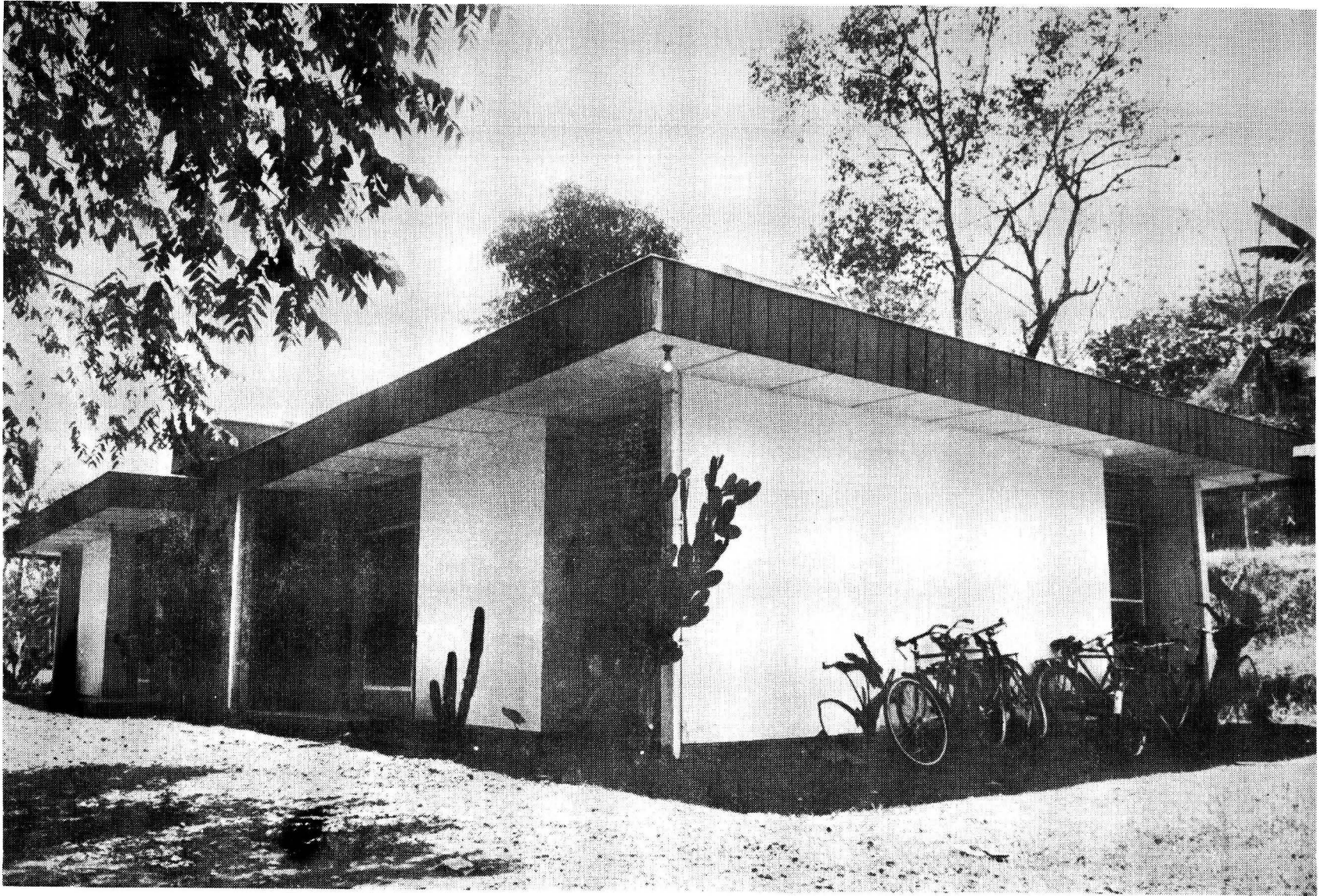
29. Gedung asrama karyawan teras unit I telah selesai dan dipakai sebagai kantor proyek. Foto ProBo 23195.
