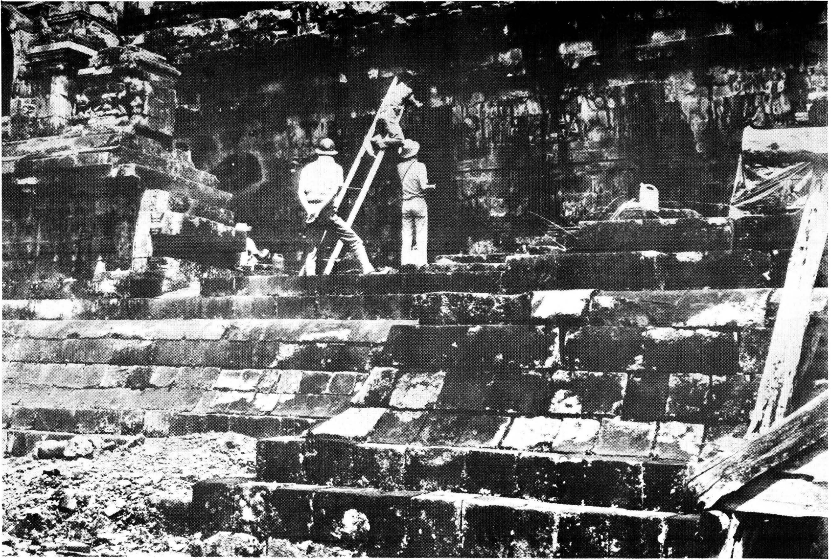
16. Penelitian terhadap air rembesan yang keluar dari dinding candi dan ditampung dalam bak plastik. Foto ProBo 4015.
