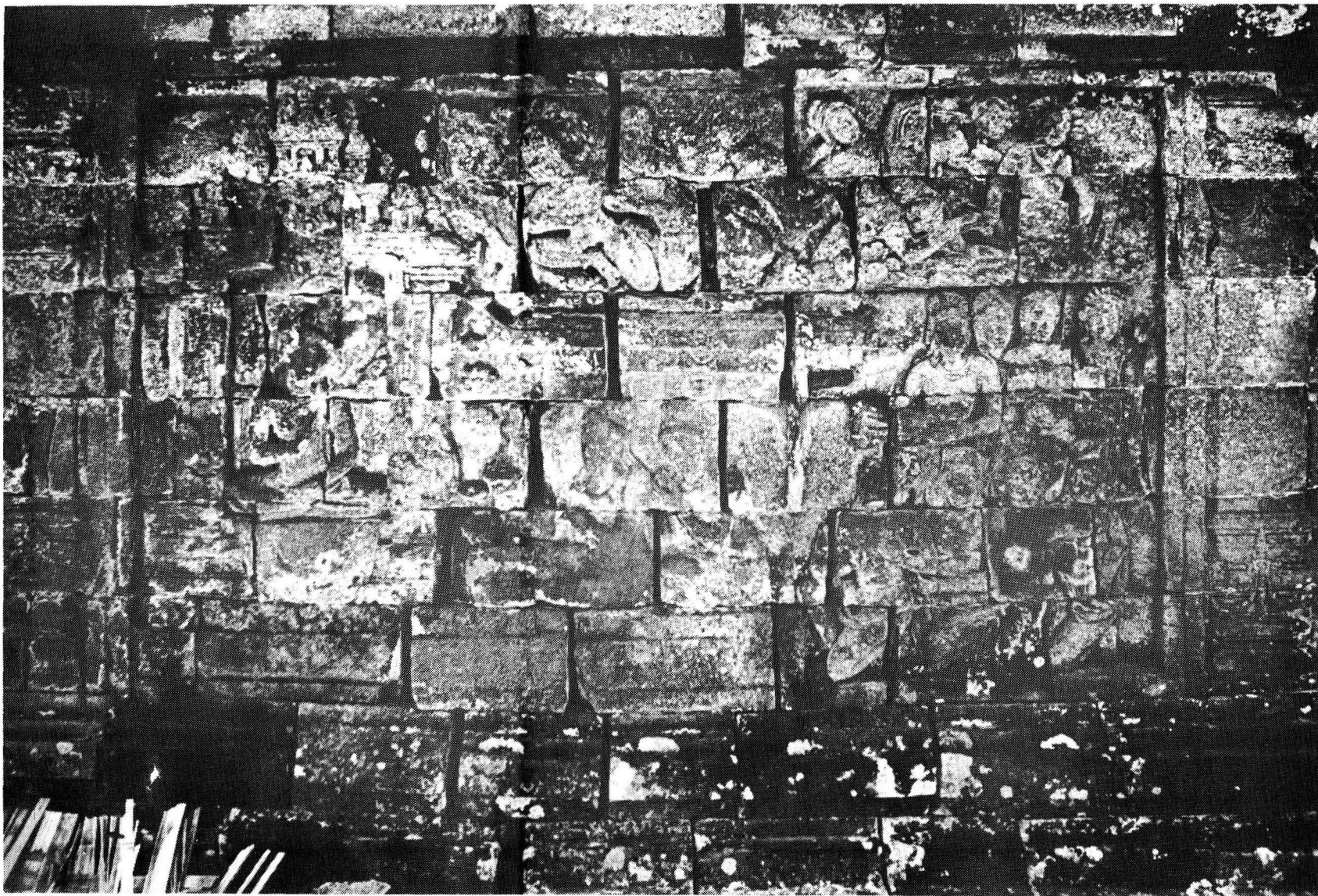
20. Contoh relief yang hampir terhapus karena terkikis oleh berbagai macam penyakit batu. Dinding lorong tingkat II sisi Barat. Foto ProBo 7496.
