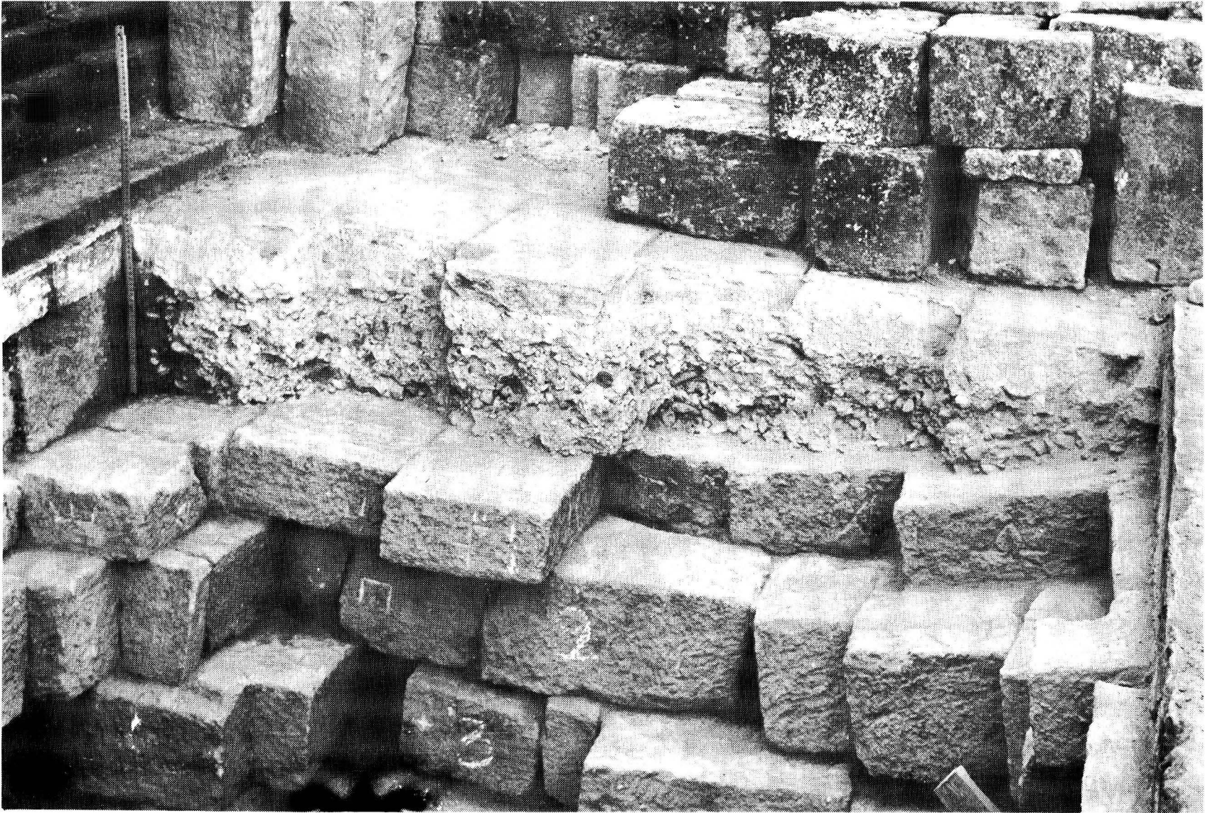
8. Pembongkaran lantai lorong buatan Van Erp untuk lobang pemboran menampakkan lantai aslinya yang miring ke dalam. Foto ProBo 3438 (lorong tingkat III sisi Barat).
