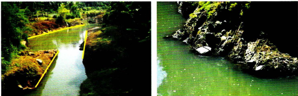
Gambar 13. Kelurusan di Sungai Tangsi utara jembatan Ringinanom (Foto: Murwanto, 2012)
