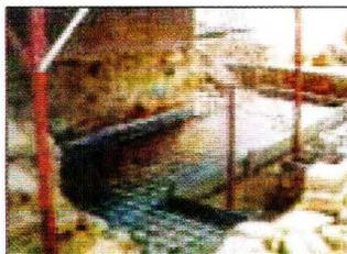
Foto 11. Perkuatan struktur dengan penambahan lapisan beton
