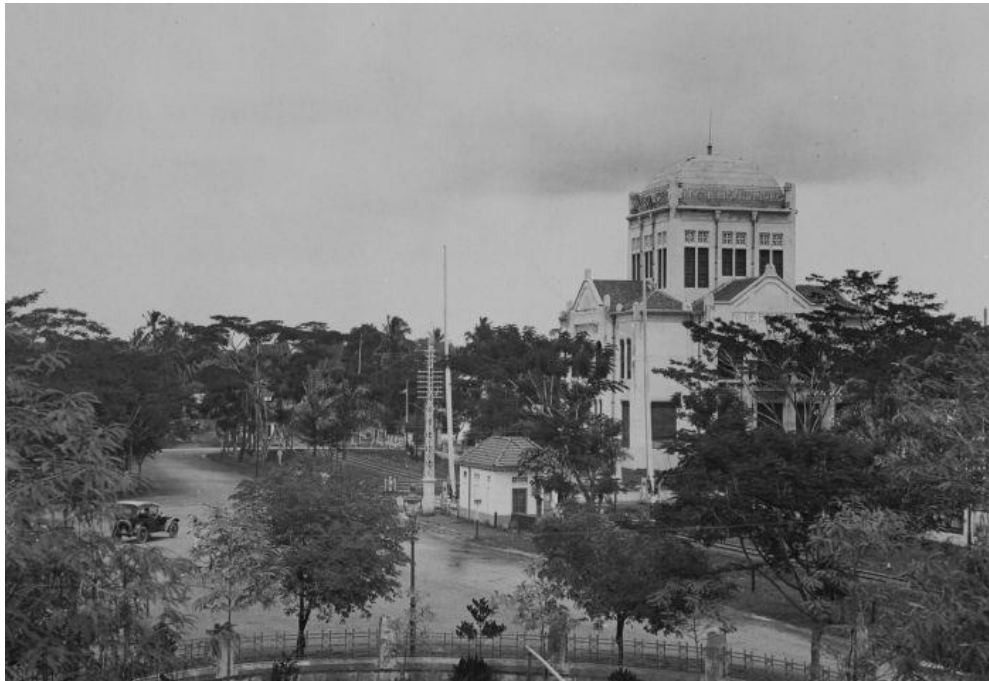
Gambar 5.2: Kantor Bouwploeg, sekarang Masjid Cut Meutia. (foto: koleksi Tropen Museum)
