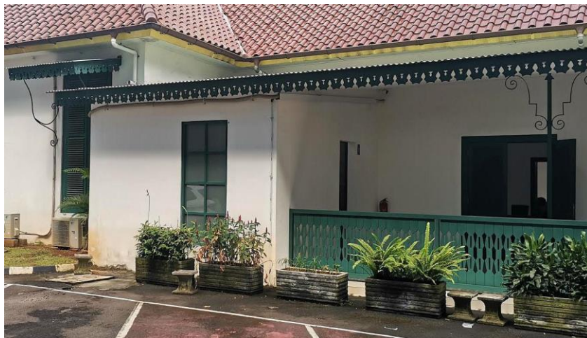
Gambar 5.46: Jendela bermaterial kayu dan kaca (Foto: Mahanizar Djohan).
