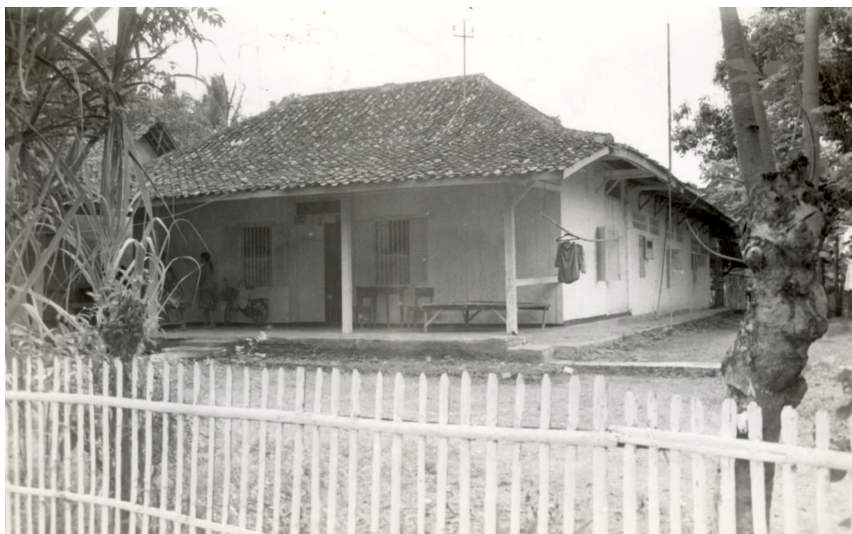
Gambar 5.38: Rumah Djiauw Kie Siong di Rengasdengklok, saksi sejarah penculikan Bung Karno dan Bung Hatta oleh para pemuda, pada 16 Agustus 1945. Foto: Kompas
