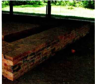
adakalanya di bagian tengah dibangun struktur tersendiri untuk menopang bagian bangunan di atasnya. Di antaranya digunakan tanah isian. Struktur dinding bangunan disusun
