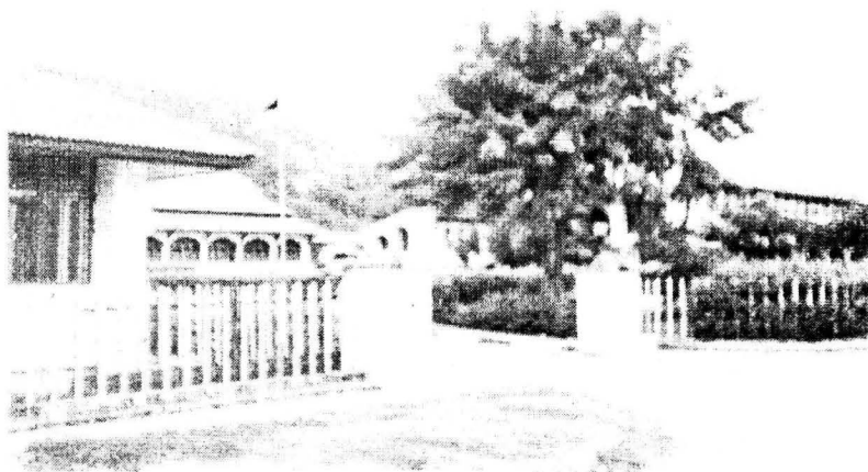
Gedung STM di Dili
