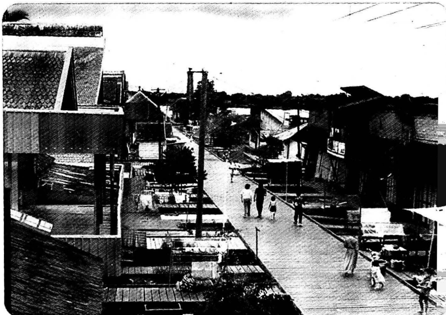
Karena jalan Desa Muara Muntai selalu terendam air bila Sungai Mahakam banjir, maka sebagian jalan desa tersebut dibuatkan jembatan kayu ulin di atasnya.
