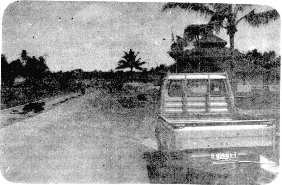
Gambar 8. Kondisi jalan dan pemukiman yang baru selesai pembangunannya, Tahun 1983.
