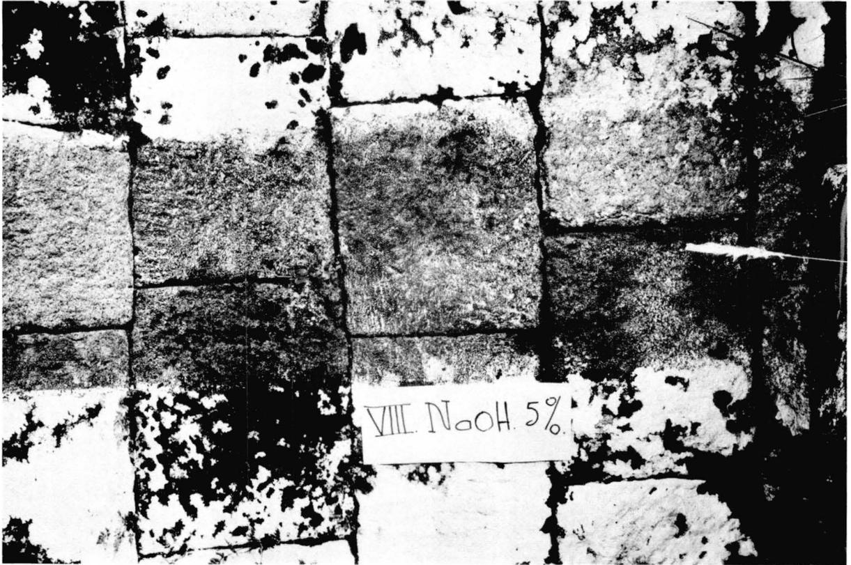
*Keadaan batu-batu dinding selasar sisi Utara setelah dibersihkan dengan NaOH 5% (Foto ProBo 7.726).*
