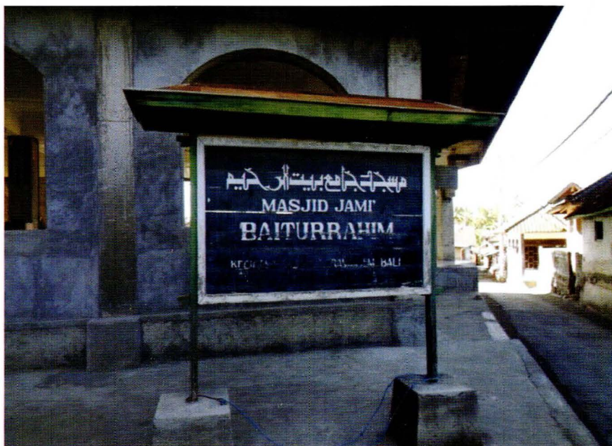
Foto 2. Bangunan Masjid Jami' Baiturrahim Banjar Kecicang Karangasem
