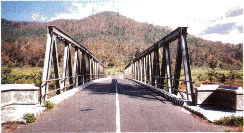
Pembangunan jembatan untuk memperlancar perhubungan, jembatan di Motahare, Kabupaten Ermera.
