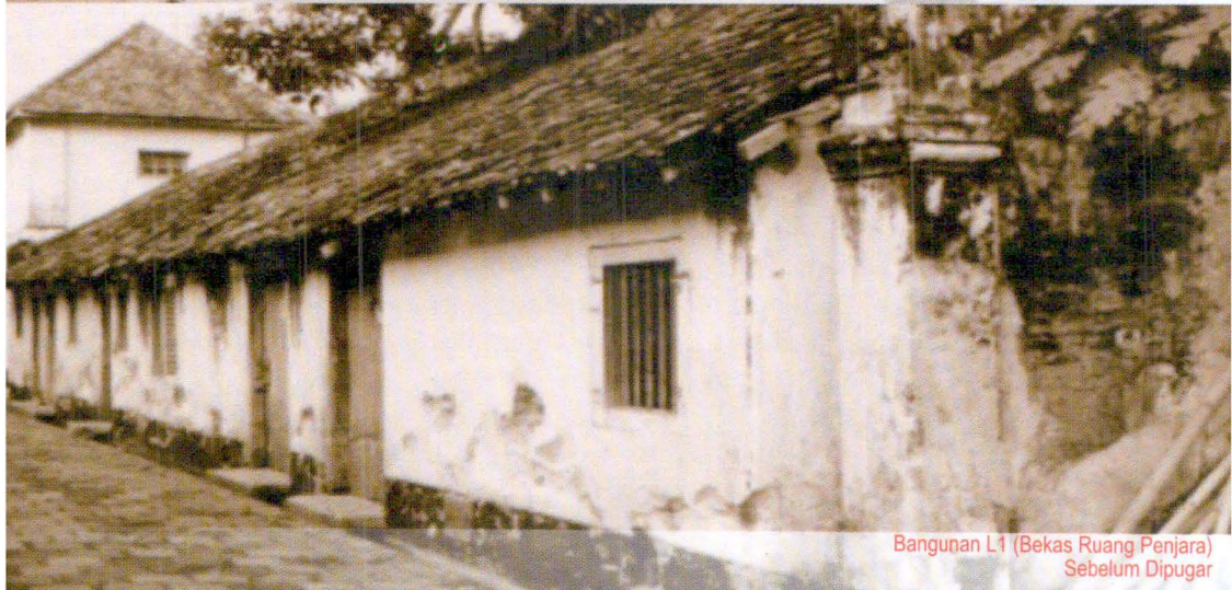
Bangunan C (Bekas Ruang Tamu VIP) Sebelum Dipugar
