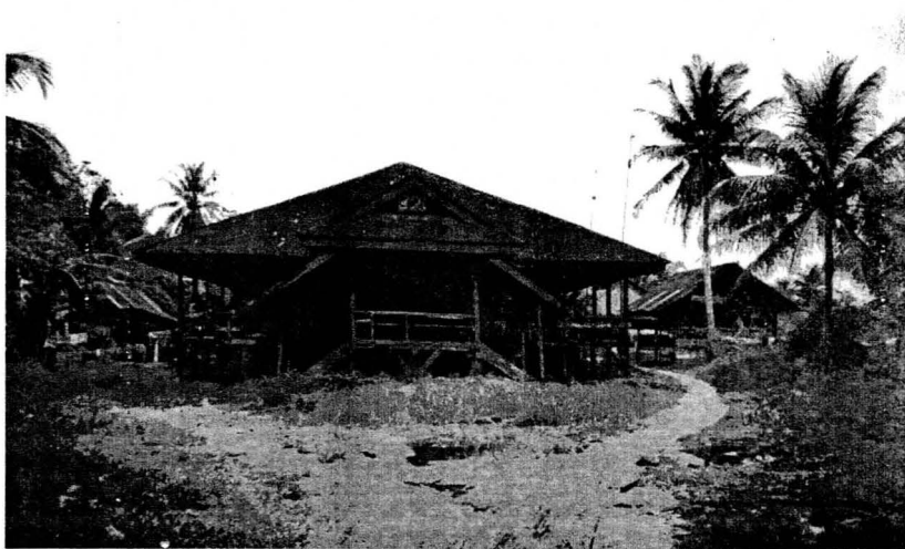
Bangunan Bangsal 4 yang terlihat masih kokoh
