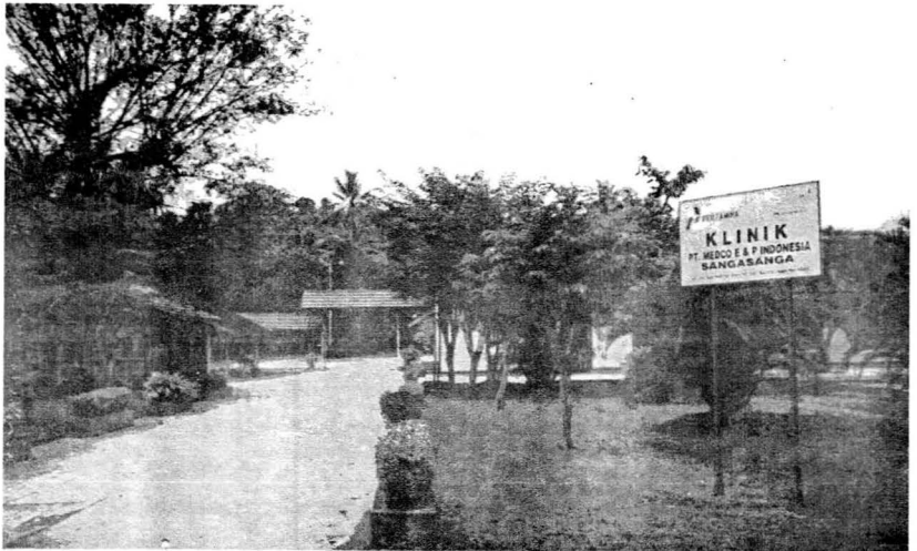
Bangunan Gedung Rumah Sakit, sekarang menjadi kKinik PT. Medco
