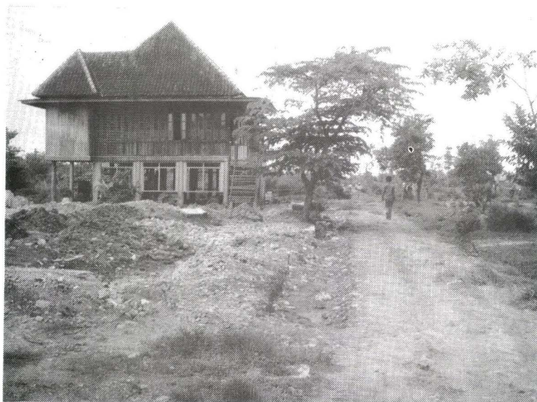
Foto 19. Kondisi tanah Pulau Nangka yang telah rusak dan rumah yang belum dibongkar (kol. Dit. Limbinjarah).
