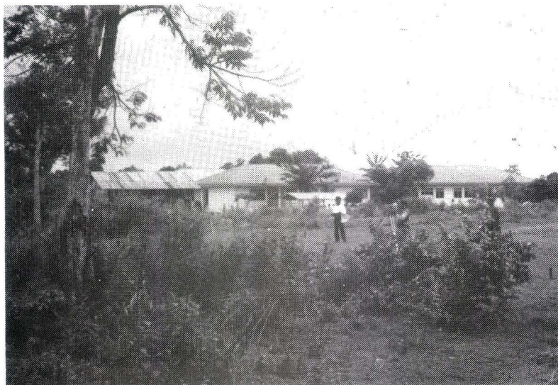
Foto 17. Bangunan SMA di Pulau Nangka (kol. Dit. Linbinjarah).
