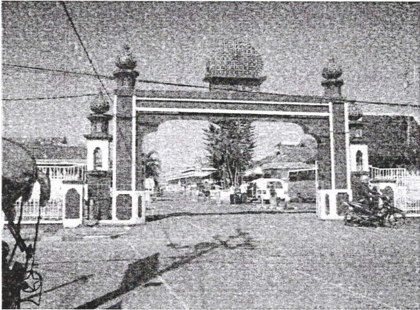
Foto.5 Pintu Gerbang Masuk lokasi Makam
