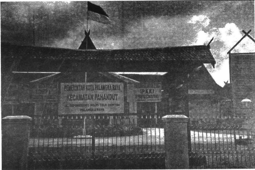
Foto 6 Kantor Kecamatan Pahandut Yang Kini Terletak di Jalan Diponegoro Palangka Raya
