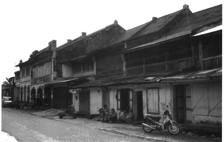
Bangunan lama di Jalan Pasar Mudik
