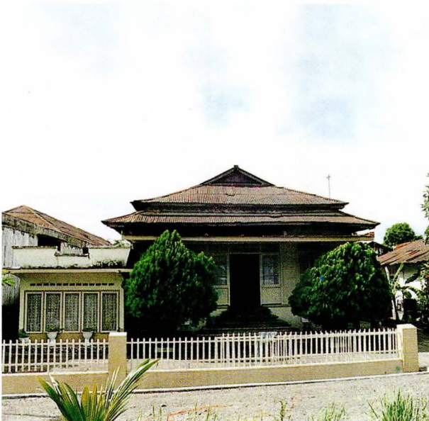
Rumah bergaya seni bangunan etnik Melayu yang mengadopsi konstruksi tembok untuk kai dan tangga masuk. Bekas rumah tinggal masinis kereta api yang terletak didaerah Palinggam. Dibangun tahun 1915.
