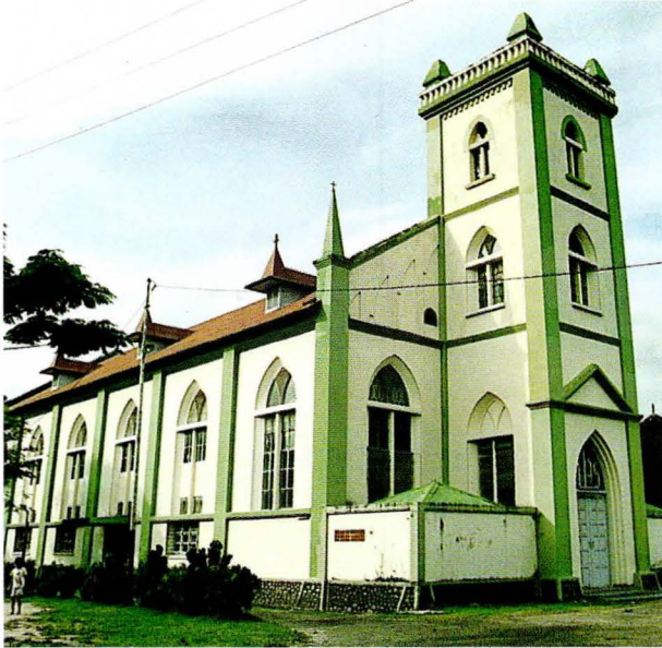
Gereja Katolik. Terletak di Jalan Gereja 43, Padang Barat. Gereja ini dibangun tahun 1933. Memperlihatkan gaya arsitektur Art Deco Geometrik yang segaya dengan Gereja St. Leo (Protestan?) yang berdiri dekat disekitarnya.
