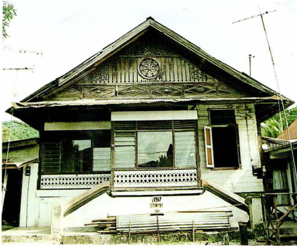
Tipe rumah tinggal masyarakat pribumi (pribayi) lainnya bergaya seni bangunan etnik Melayu. Terletak di daerah Palinggam dan dibangun tahun 1917.
